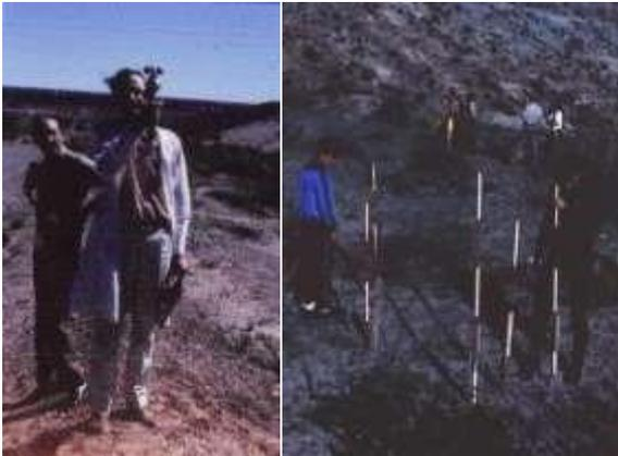
En estas imágenes se observan la utilización de un anemómetro para determinar orientación y velocidad del viento. En la imagen adjunta se observan auxiliares fijando las estacas en los puntos de señalización.
